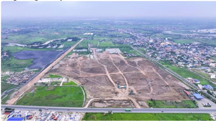
Hình 3: KCN Tràng Duệ 03, với việc san lấp và xây dựng hạ tầng cho giai đoạn 1
